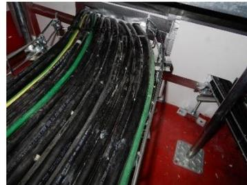
*Figura 2. Fotografía de comunicación de cables, se observa ausencia de parche ignífugo. La comunicación de fuego entre salas es posible*
